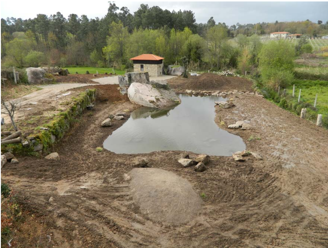
25-03-2013 Vista da janela do Alojamento Lago( em construção)
