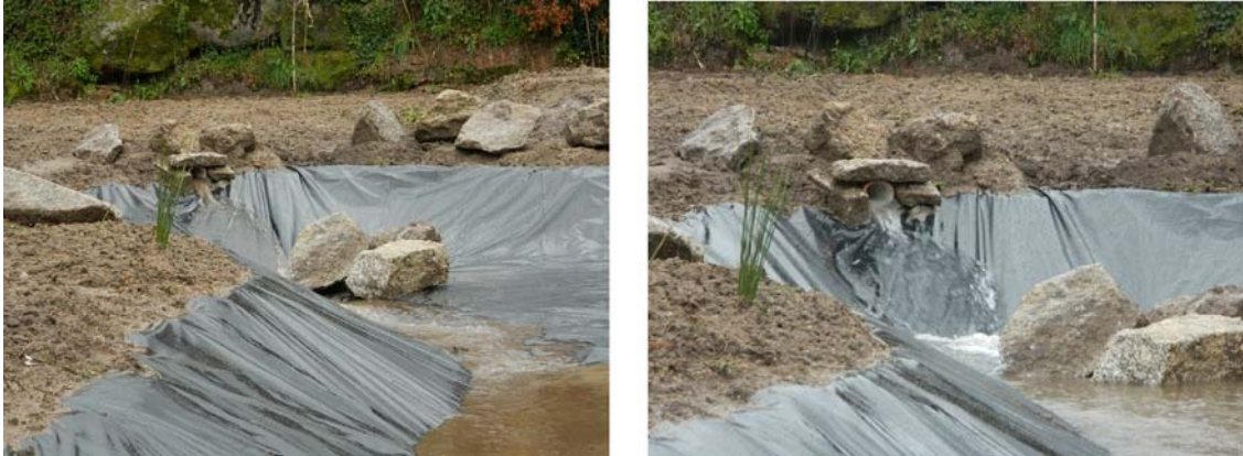
12-03-2013 Pormenor da entrada de água no lago
