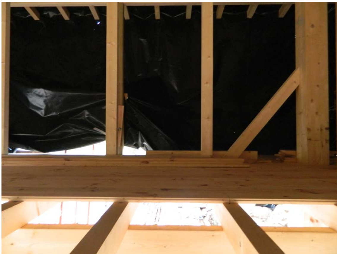
08-03-2013 Continuação da colocação do ripado no elemento construído
