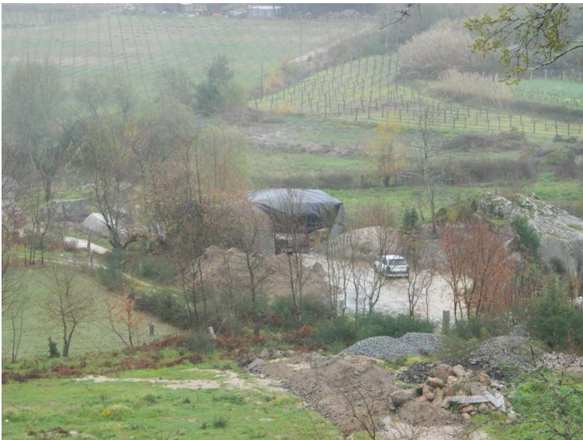
07-03-2013 Proteção do elemento construído
