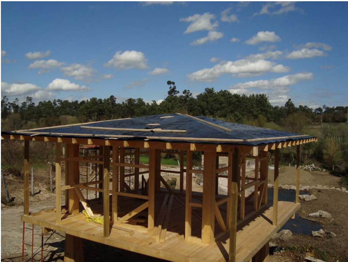
21-03-2013 Continuação do processo de impermeabilização da cobertura, colocação da tela
