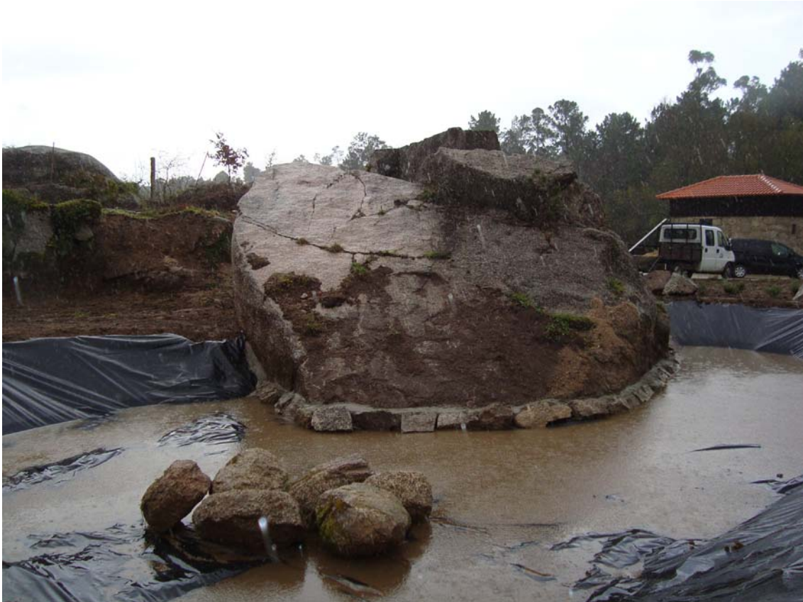
11-03-2013 Detalhe de colocação da tela junto ao afloramento rochoso
