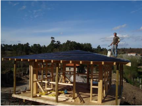
20-03-2013 Evolução dos trabalhos no alojamento lago, impermeabilização da cobertura
