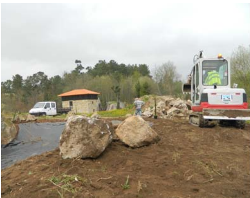
06-03-2013 Colocação de elementos inertes e plantações
