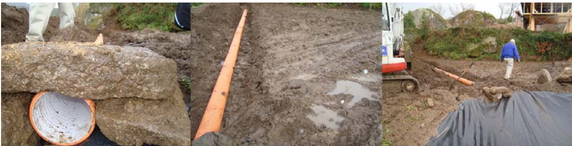
11-03-2013 Entrada de água no elemento e respetiva canalização
