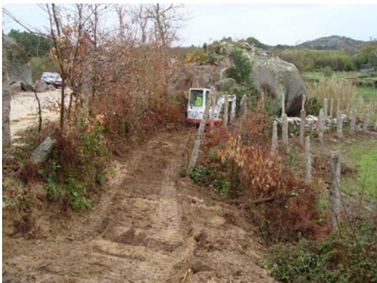
11-03-2013 Continuação da limpeza e despedrega
