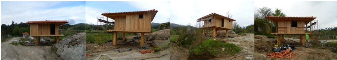
2-04-2013 Continuação da execução do elemento construído
