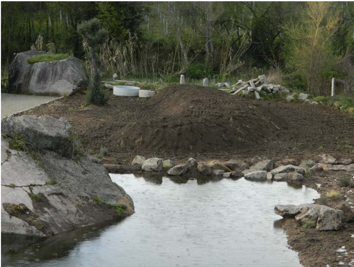
25-03-2013 Vista da janela do Alojamento Lago( em construção) - Pormenor
