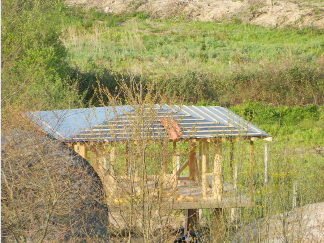
21-03-2013 Continuação do processo de formalização da cobertura, colocação do ripado
