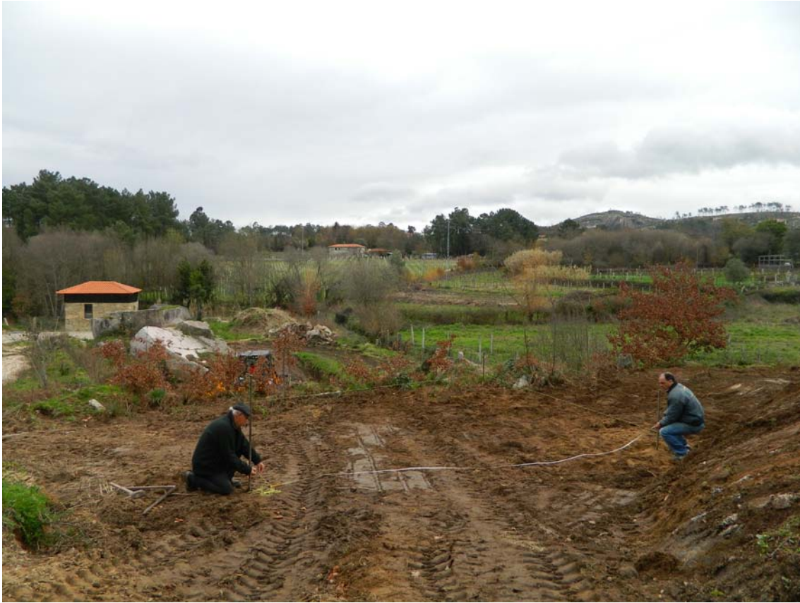
29-01-2013 Início da implantação planimétrica do Alojamento Lago
