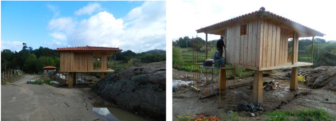
2-04-2013 Continuação da execução do elemento construído
