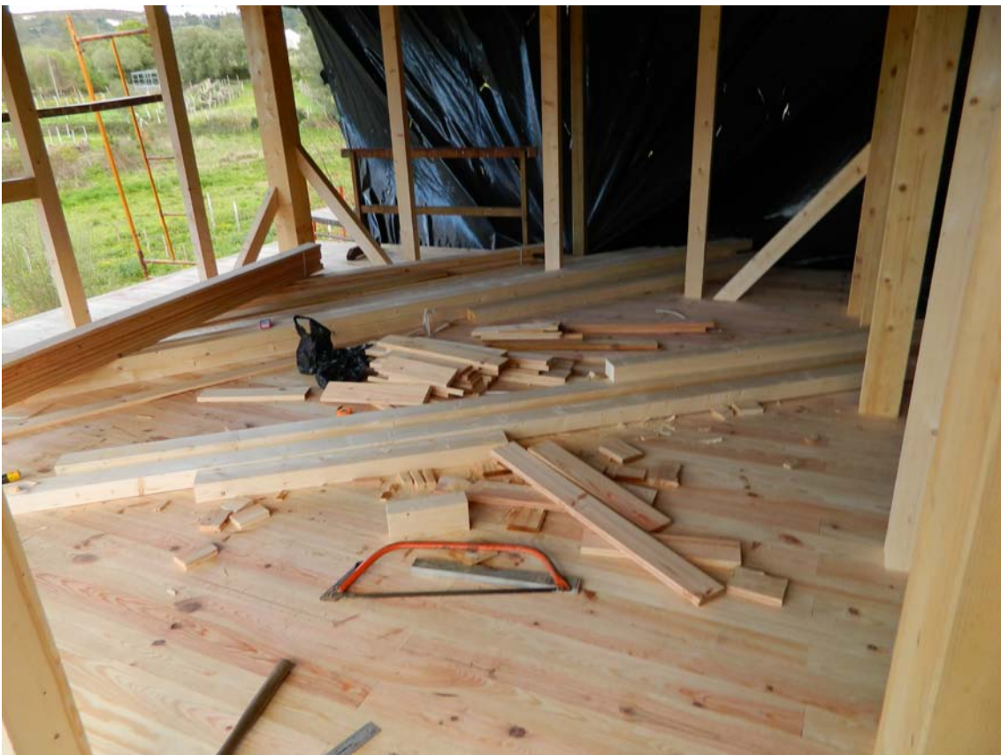
12-03-2013 Continuação dos trabalhos no elemento construído
