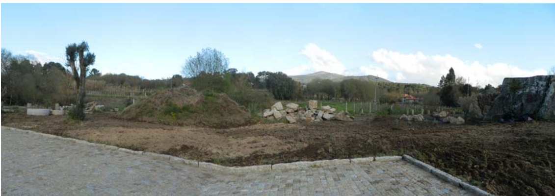
07-03-2013 Continuação da limpeza e despedrega
