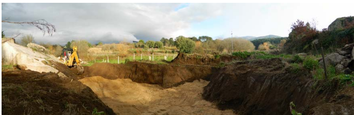
29-01-2013 Limpeza Despedrega e Formalização do Lago Naturalizado
