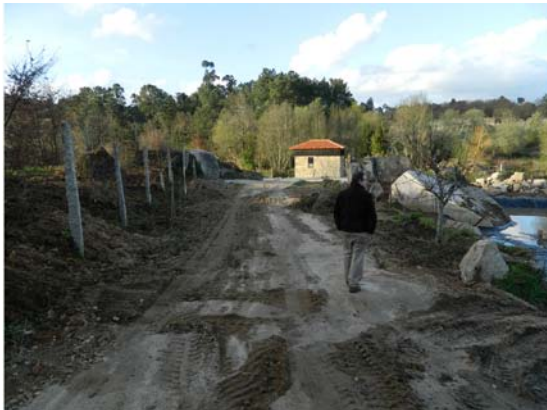
07-03-2013 Continuação da limpeza e despedrega
