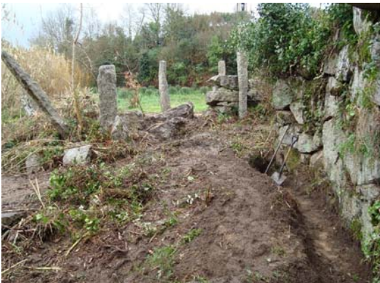
11-03-2013 limpeza e consolidação do canal de passagem de água
