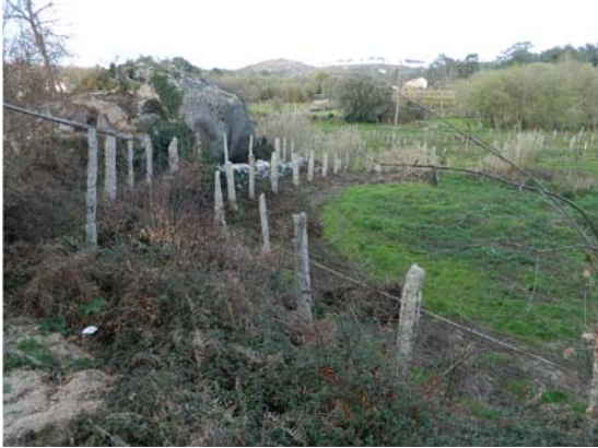
07-03-2013 Continuação da limpeza e despedrega
