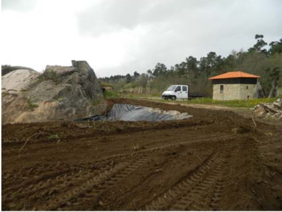
06-03-2013 Colocação da tela impermeabilizante no lago naturalizado
