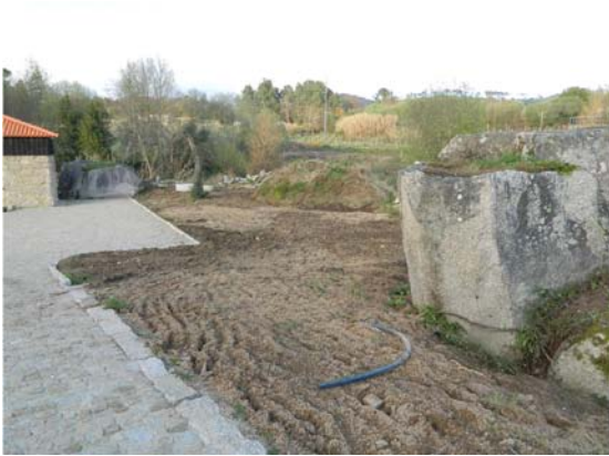
07-03-2013 Continuação da limpeza e despedrega
