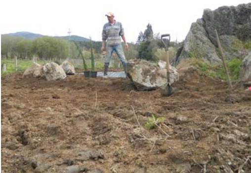
06-03-2013 Colocação de elementos inertes e plantações
