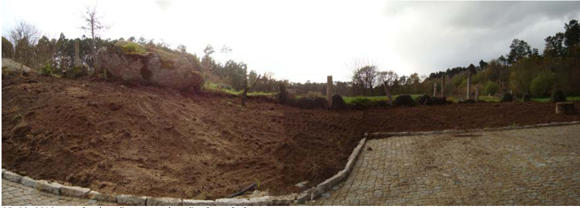
25-03-2013 Regularização e suavização de taludes
