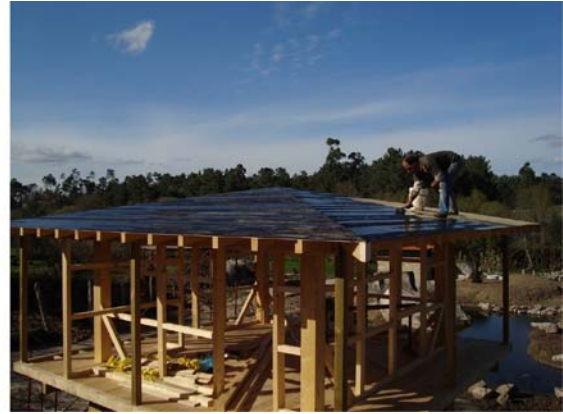
20-03-2013 Evolução dos trabalhos no alojamento lago, impermeabilização da cobertura
