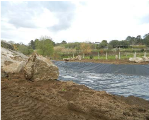
06-03-2013 Colocação de elementos inertes e plantações
