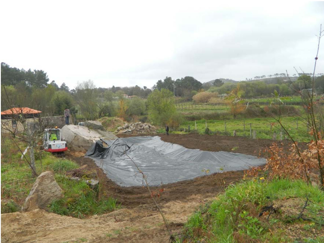
06-03-2013 Colocação da tela impermeabilizante no lago naturalizado
