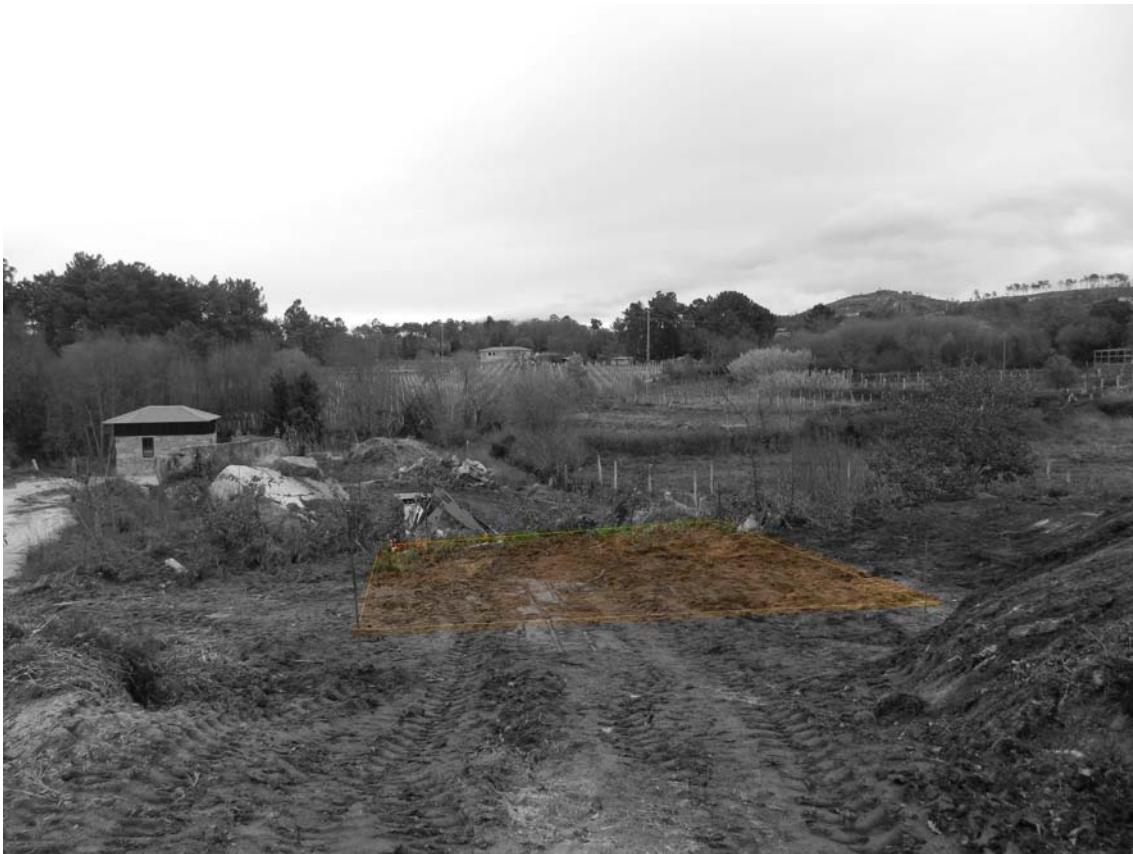
29-01-2013 Início da implantação planimétrica do Alojamento Lago
