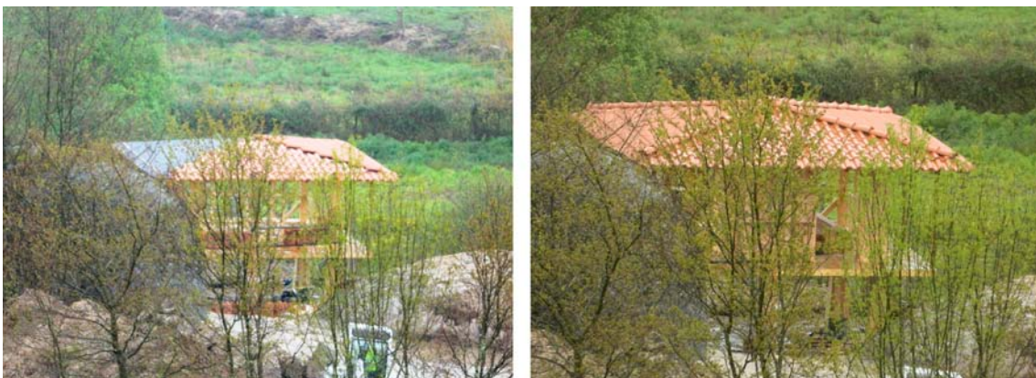
02-04-2013 Finalização da cobertura do elemento construído
