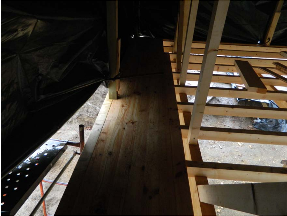
07-03-2013 Início do assentamento do ripado da base no alojamento lago
