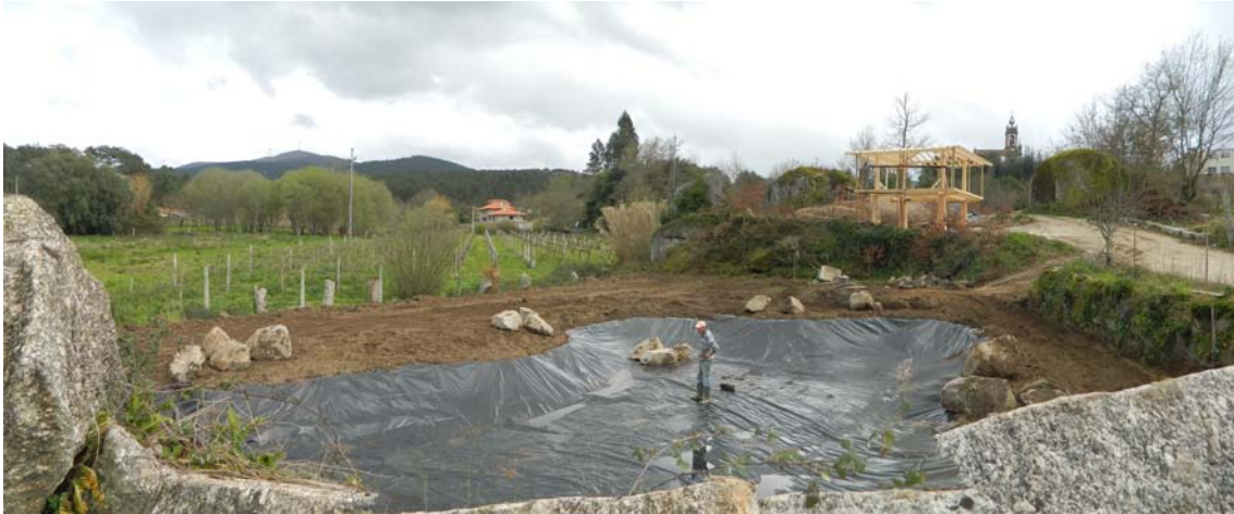
06-03-2013 Colocação de elementos inertes e plantações
