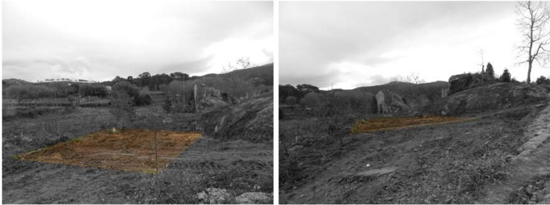
29-01-2013 Início da implantação planimétrica do Alojamento Lago
