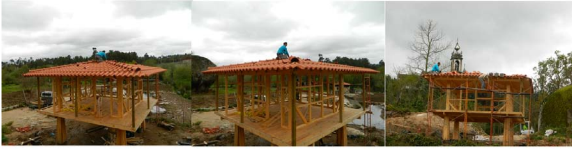
02-04-2013 Finalização da cobertura do elemento construído
